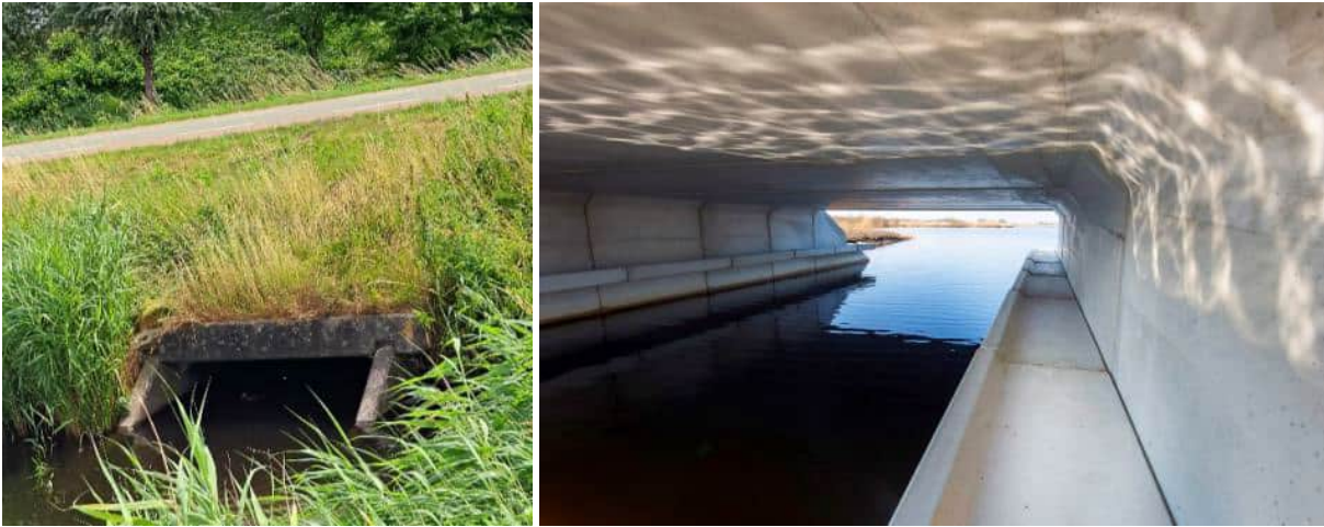
Linker afbeelding: duiker Vronermeerweg; rechter afbeelding: loopstrook in duiker (bron: It Fryske Gea)
